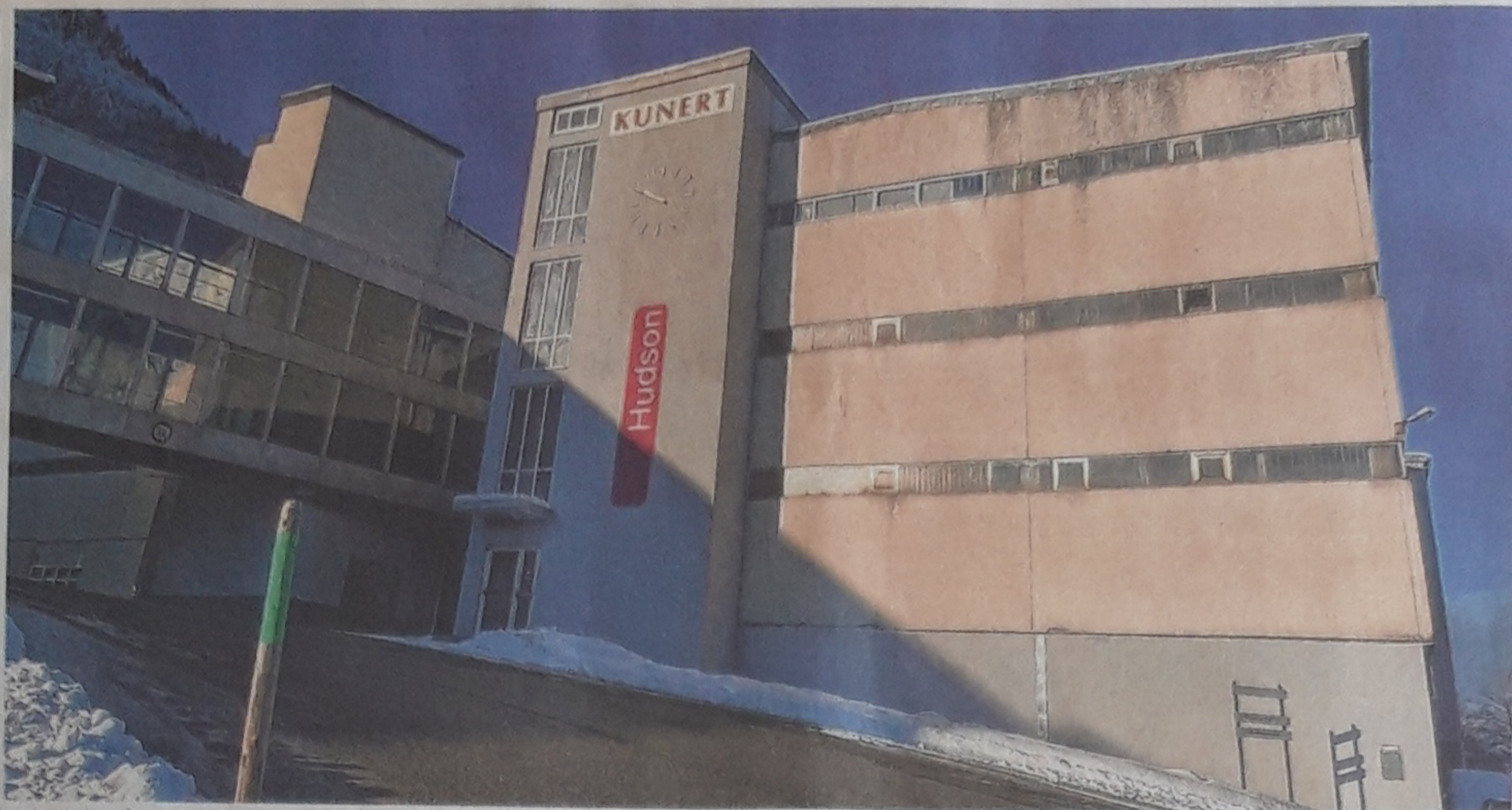
Viele Gebäude auf dem Werksgelände oberhalb des kleinen Alpsees stehen inzwischen leer. Produziert wird am Kunert-Standort in Immenstadt seit dem Aus für die Feinstrickerei im Jahr 2020 nicht mehr.
